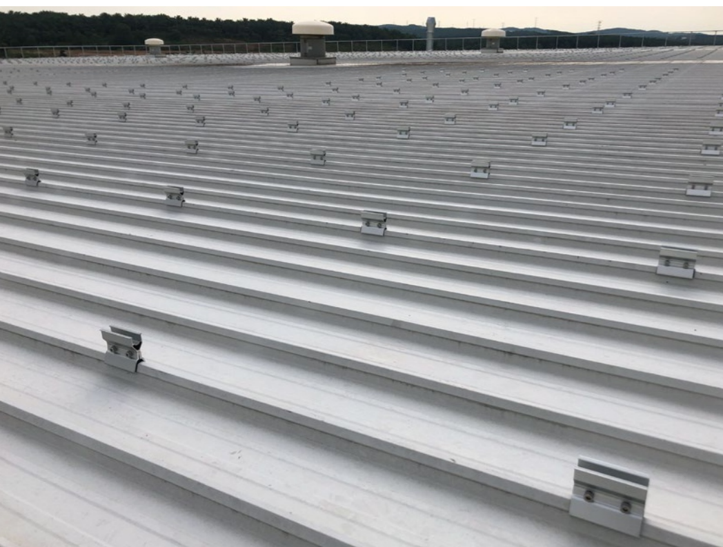
Montáž na plechové střeše- Malajsie
