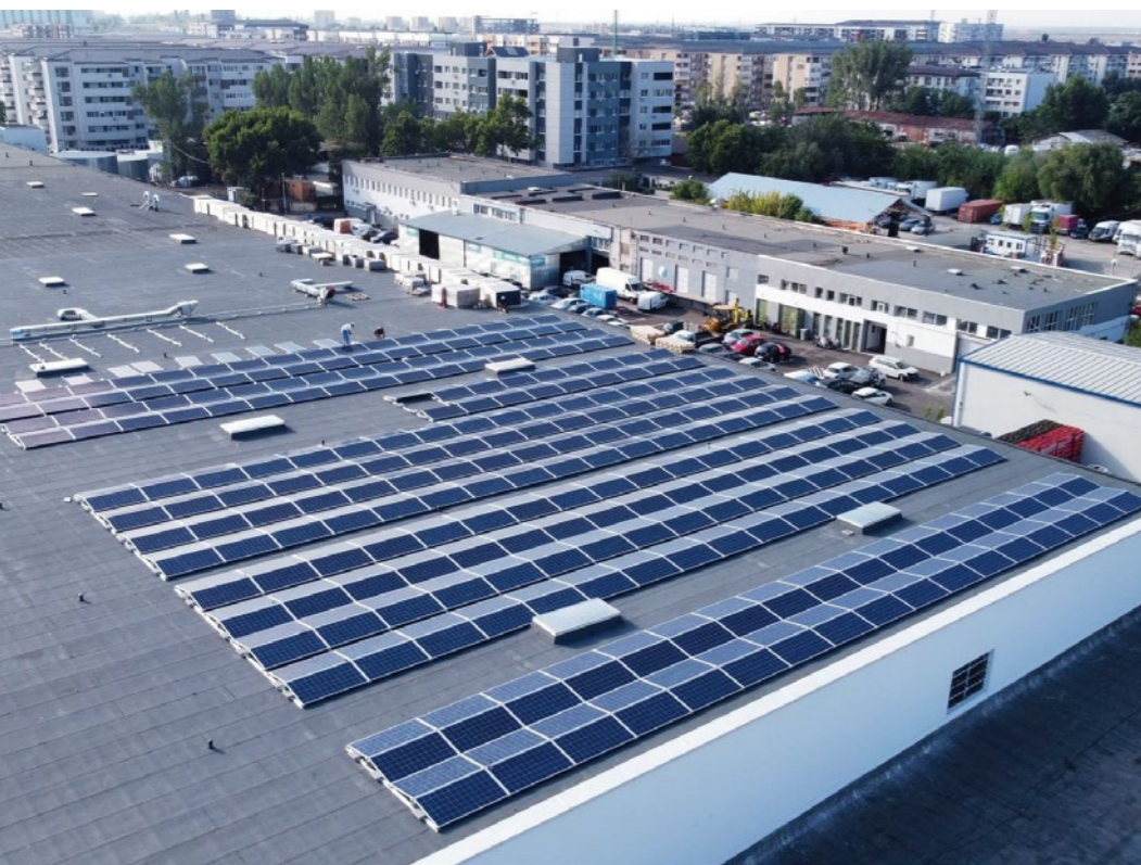
Montáž se zátěžovými deskami PRO, orientace východ - západ - Rumunsko
