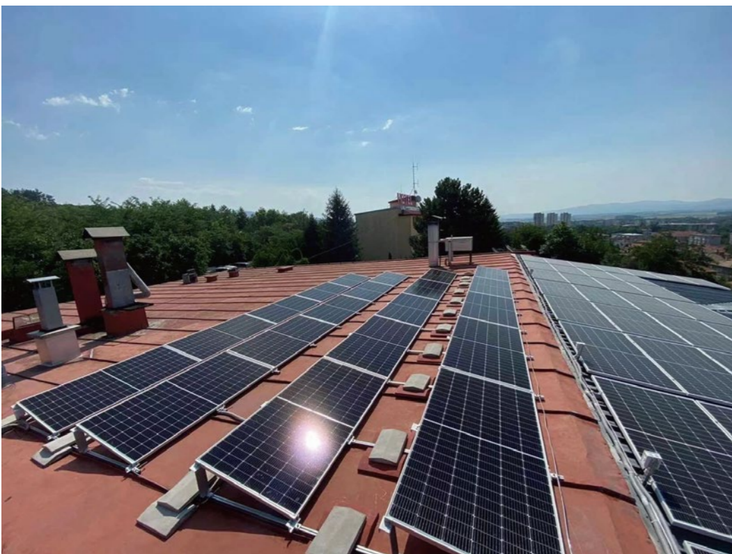
Montáž se zátěžovými deskami, orientace východ a západ - Bulharsko
