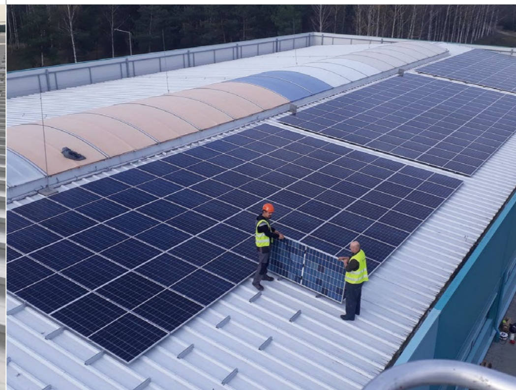
Montáž na plechové střeše - Polsko
