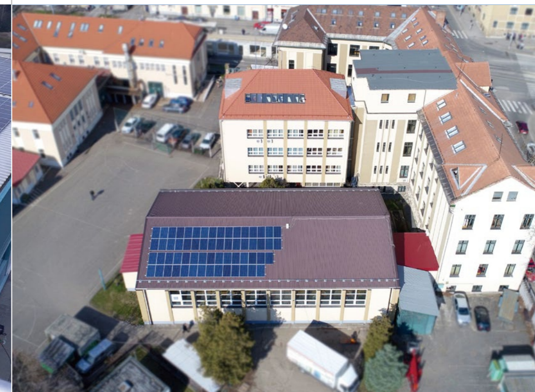
Montáž na taškové střeše - Maďarsko
