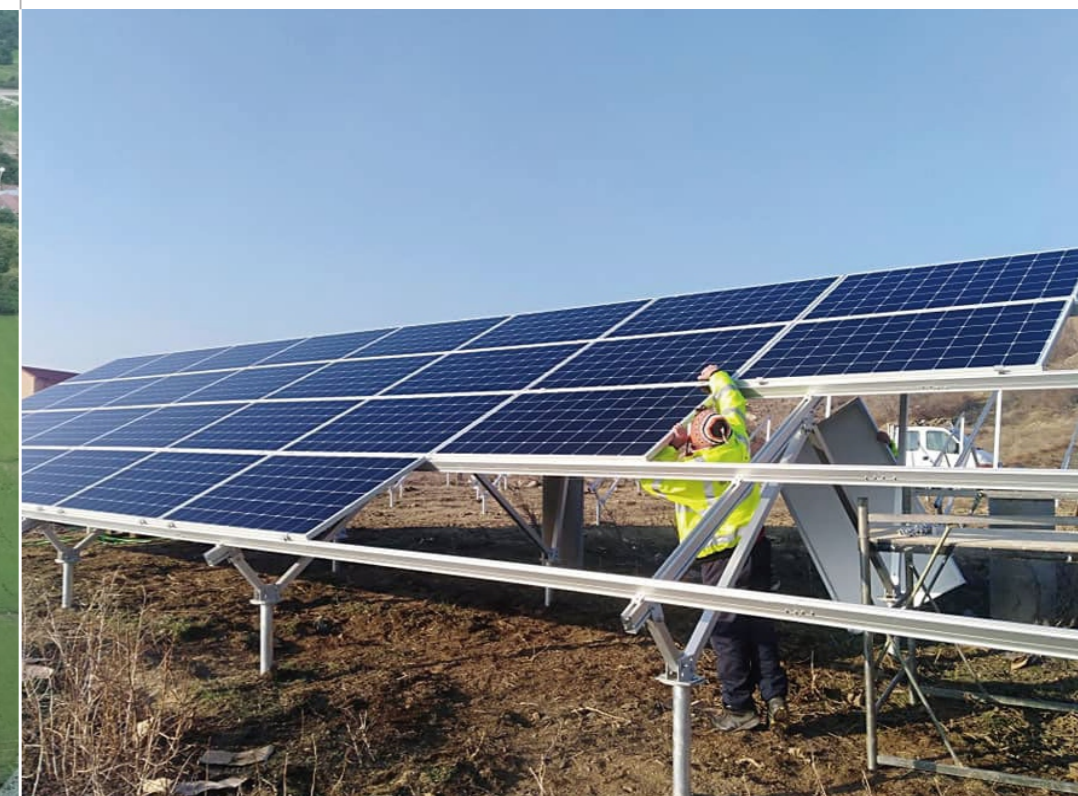
Montáž na zemi - Rumunsko
