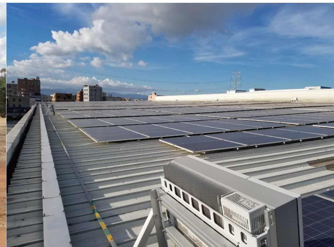
Montáž na plechové střeše - Čína
